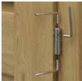
regulacja zawiasów czopowych regulowanych 3D
